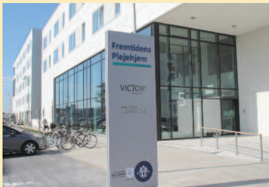
Fremtidens plejehjem i Nørresundby på en af byens dyreste byggegrunde med egen restaurant og udsigt over fjorden.
